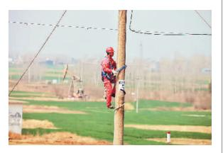
近日,河南油田水电厂供电运维站启动2023年春季 电网检修工作,组织20名外线员工对总长度103公里的 12条电力线路进行停电检修,为电网安全可靠运行奠定 基础。图为外线员工攀登杆塔开展检修作业。
