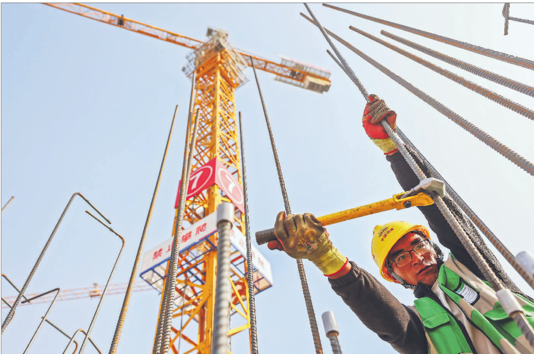
3月29日,河北雄安新区,由中铁十二局承建的雄东片区B单元安置房项目施工现场,来自云南的钢筋工罗金保正在用套丝连接钢筋。该项目建成后将迎来2075户雄安居民。
